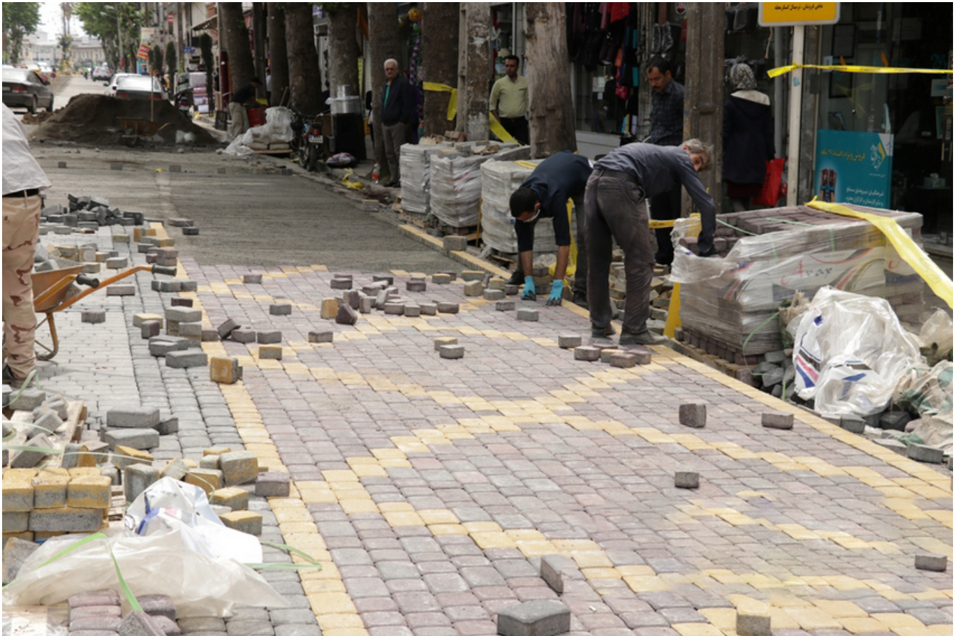
مناقصه اجرای کف سازی خیابان بسیج
